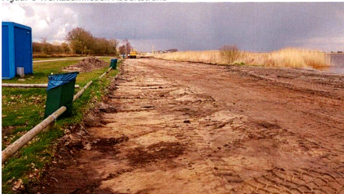
Figuur 8 Werkzaamheden Abbertstrand
