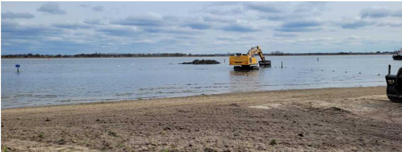
Werkzaamheden voor het zwemseizoen bij Rivière Beach Noord in Biddinghuizen
