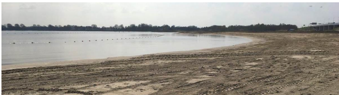
Zilverstrand in aanleg
