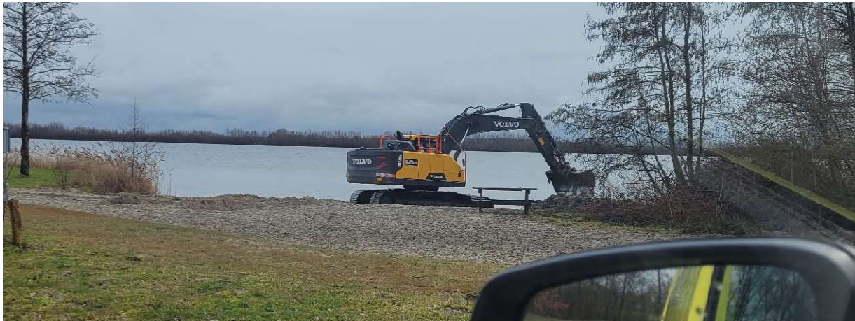
Werkzaamheden voor het zwemseizoen bij Erkermederstrand te Zeewolde,
